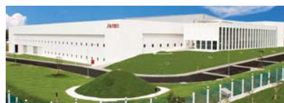
2009 資生堂 ベトナム工場
